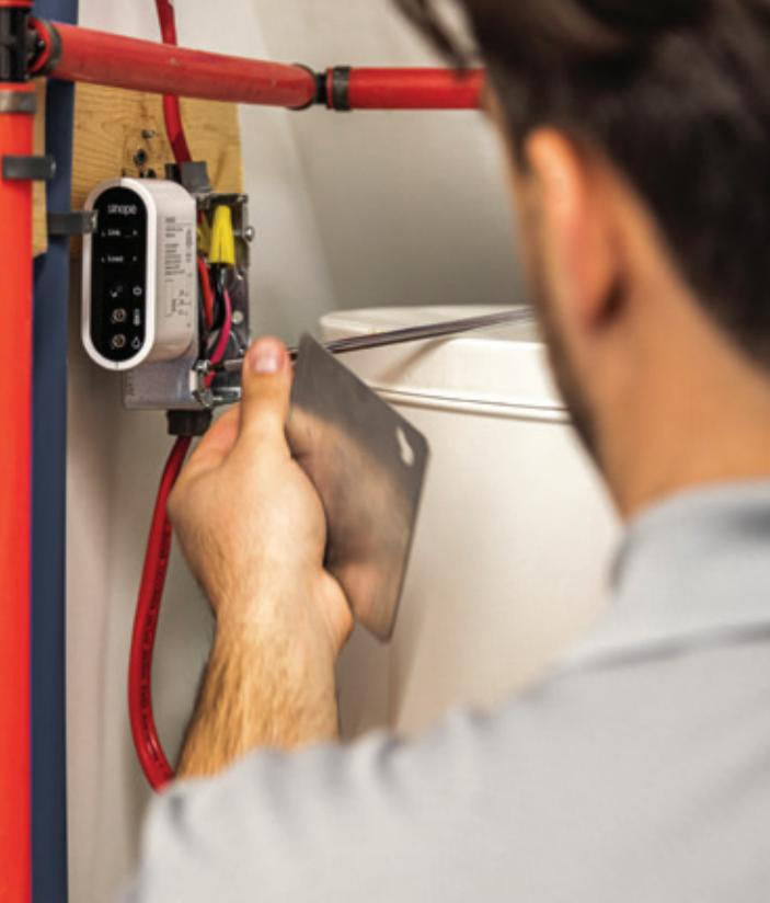
◀ Le contrôleur de chauffe-eau permet de **contrôler à distance l'alimentation du chauffe-eau** en accumulant des économies.
